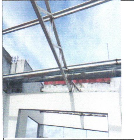
FOTO - 34 - CALHA EM CHAPA DE AÇO GALVANIZADO NÚMERO 24, DESENVOLVIMENTO DE 50 CM, INCLUSO TRANSPORTE VERTICAL.AF_07/2019
