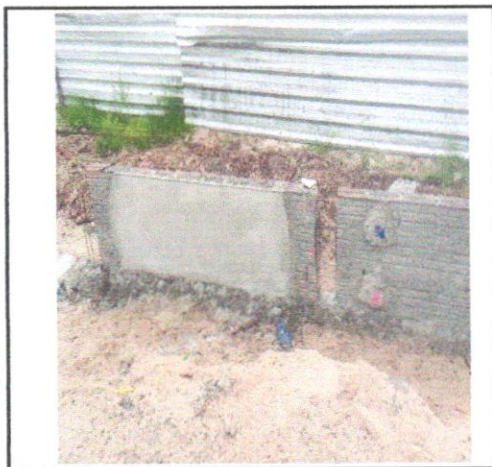
FOTO - 27 - Emboço paulista para paredes externas traço 1:2:9 - preparo manual - espessura 2,5 cm
