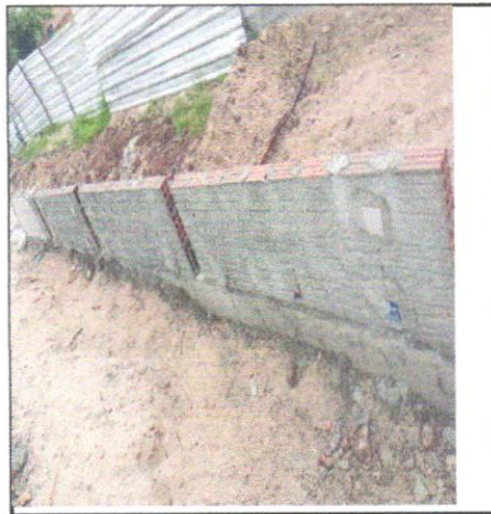
FOTO - 28 - CHAPISCO APLICADO EM ALVENARIAS E ESTRUTURAS
