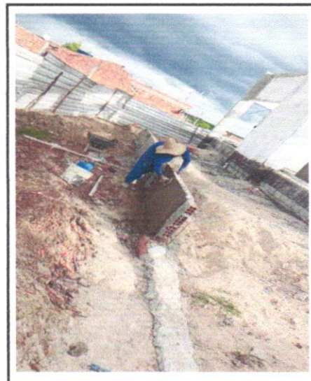
FOTO - 20 - Emboço paulista para paredes externas traço 1:2:9 - preparo manual - espessura 2,5 cm
