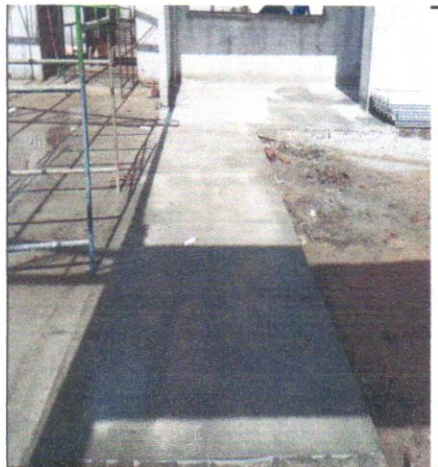
FOTO - 40 - PISO CIMENTADO, TRAÇO 1:3 (CIMENTO E AREIA), ACABAMENTO LISO, ESPESSURA 2,0 CM, PREPARO MECÂNICO DA ARGAMASSA. AF_09/2020
