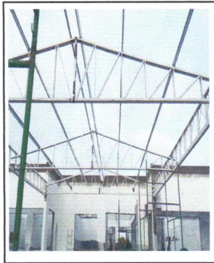
FOTO - 06 - TRAMA DE AÇO COMPOSTA POR TERÇAS PARA TELHADOS DE ATÉ 2 ÁGUAS PARA TELHA
