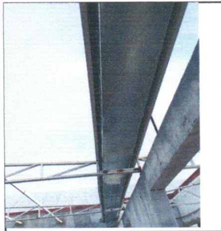
FOTO - 36 - CALHA EM CHAPA DE AÇO GALVANIZADO NÚMERO 24, DESENVOLVIMENTO DE 50 CM, INCLUSO TRANSPORTE VERTICAL.AF_07/2019
