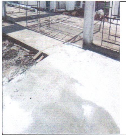
FOTO - 40 - PISO CIMENTADO, TRAÇO 1:3 (CIMENTO E AREIA), ACABAMENTO LISO, ESPESSURA 2,0 CM, PREPARO MECÂNICO DA ARGAMASSA. AF_09/2020
