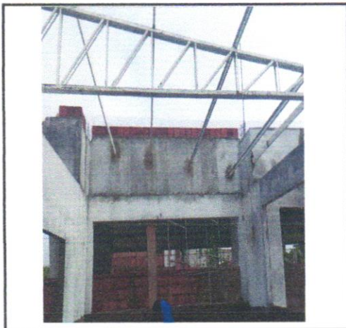
FOTO - 25 - TRAMA DE AÇO COMPOSTA POR TERÇAS PARA TELHADOS DE ATÉ 2 ÁGUAS PARA TELHA
