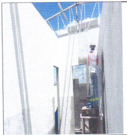
FOTO - 32 - APLICAÇÃO MANUAL DE MASSA ACRÍLICA
