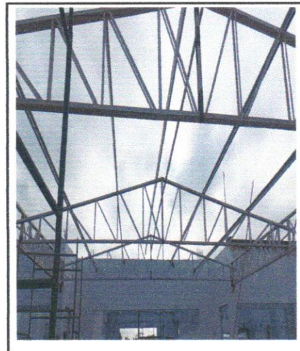
FOTO - 08 - TRAMA DE AÇO COMPOSTA POR TERÇAS PARA TELHADOS DE ATÉ 2 ÁGUAS PARA TELHA
