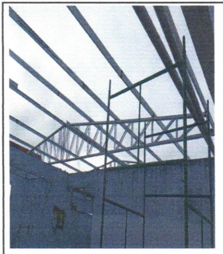
FOTO - 07 - TRAMA DE AÇO COMPOSTA POR TERÇAS PARA TELHADOS DE ATÉ 2 ÁGUAS PARA TELHA
